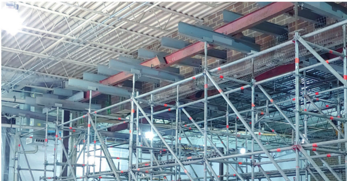
Soporte de viga de espiga en muro de ladrillo y elementos de estructura de techo existentes
