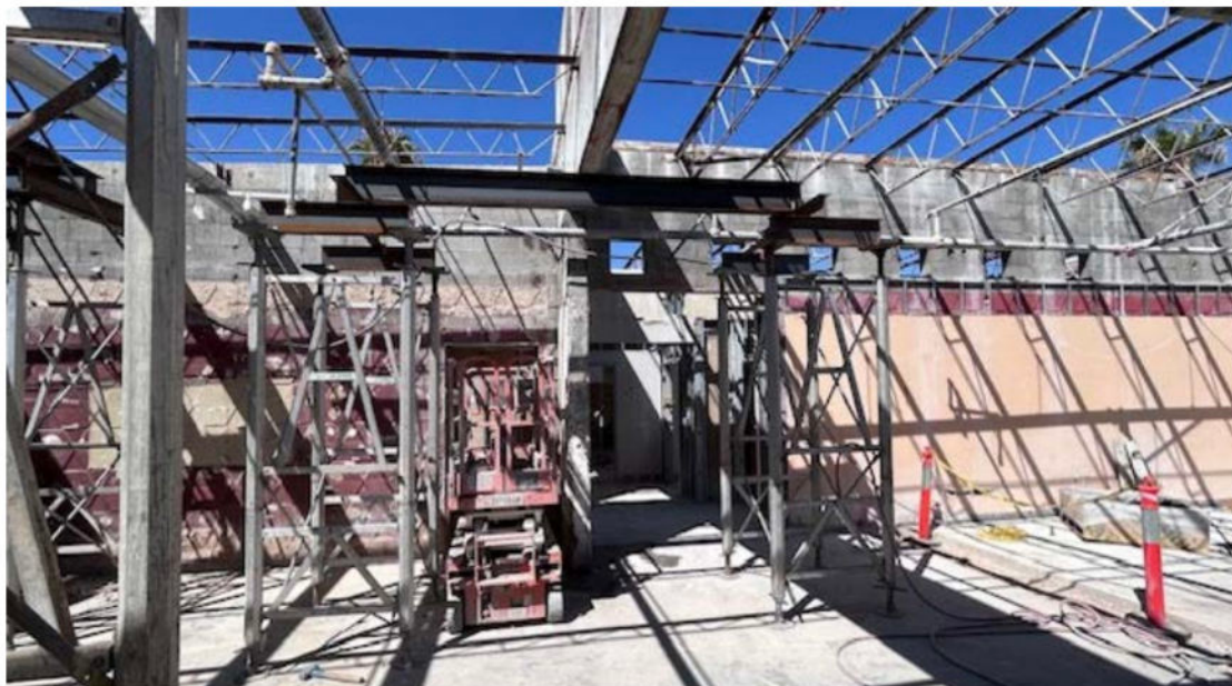
Viga de espiga con torres de apuntalamiento de marco que sostienen las vigas de pared y techo
