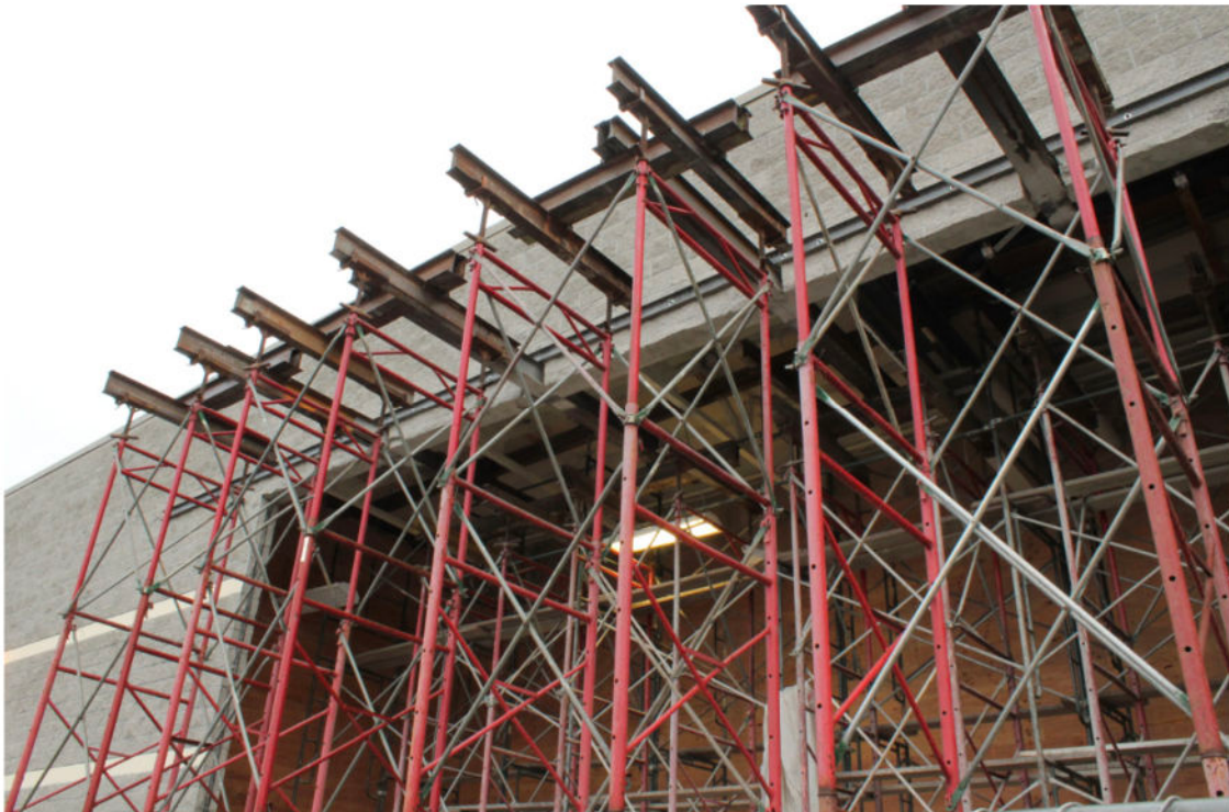
Apuntalamiento de muro de CMU para nueva abertura. Se instalaron soportes de canal en C para brindar apoyo adicional al muro junto con vigas de espiga y apuntalamiento del marco.
